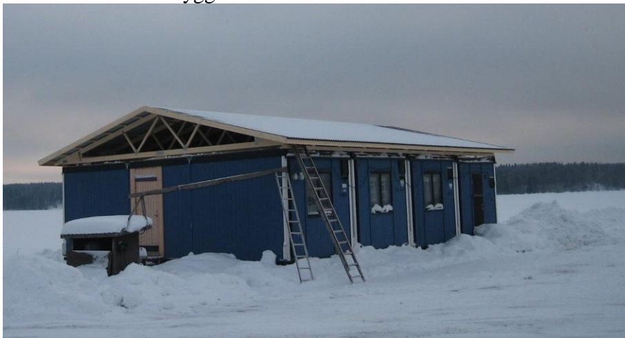
Taket är på plats, men ännu återstår en del.
